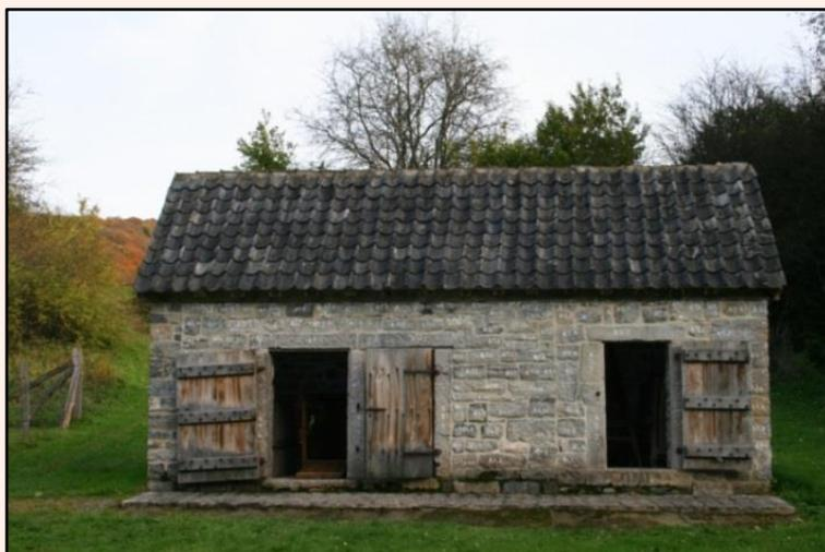
È un porcile costruito in calcare disposto in strati orizzontali composti da tre file chiamate "soues" con apertura frontale. Il lato destro è stato convertito in un bagno e un forno è stato attaccato alla parte sinistra durante la prima metà del 20 ° secolo.
